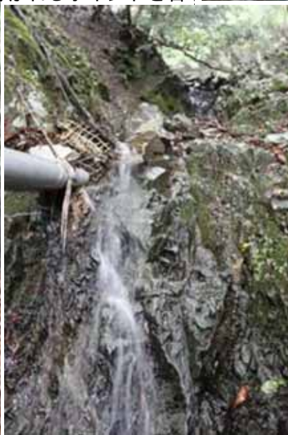
このパイプから、ドラム缶に水がためられホースで各小屋の水場へと行く
