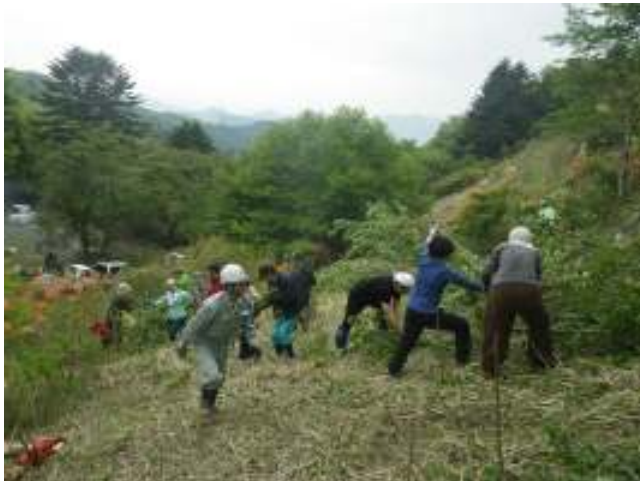
水沼山つつじ公園の整備作業
